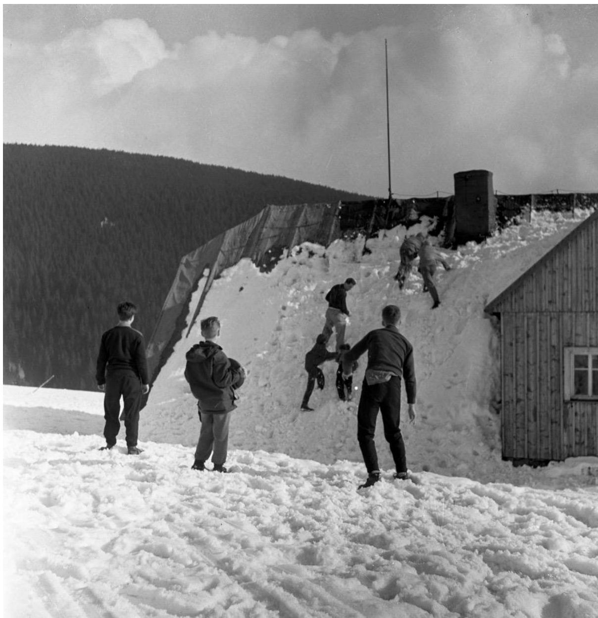
Foto 23 Skočka v zimě před opravou 1957/8?
