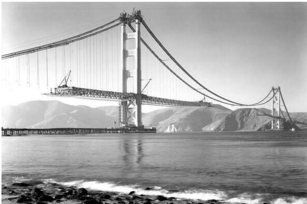
Stavba Golden Gate Bridge v roce 1937
